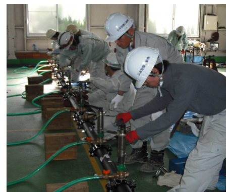
分岐穿孔作業講習
